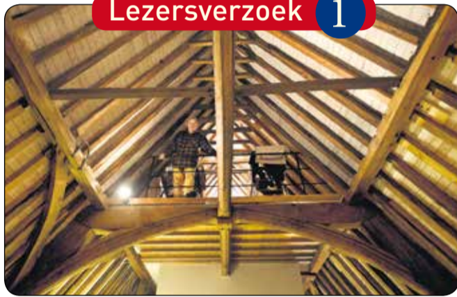
> Bewoner Jeroen op zolderverdieping van het hoofdgebouw in het Remonstrantse hofje
